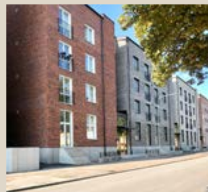
Gjuteriet etapp 1, Eskilstuna. 262 hyresrätter sålda till Slättö.
